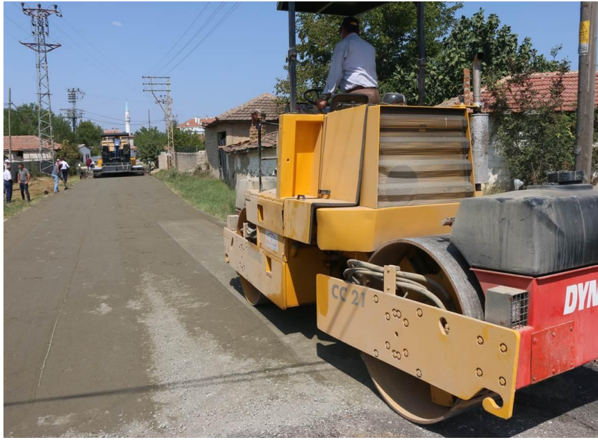
Silindir ile sıkıştırılmış (SSB) beton yol yapımı.
