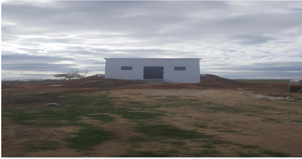
Doğanca İçme Suyu Deposu
