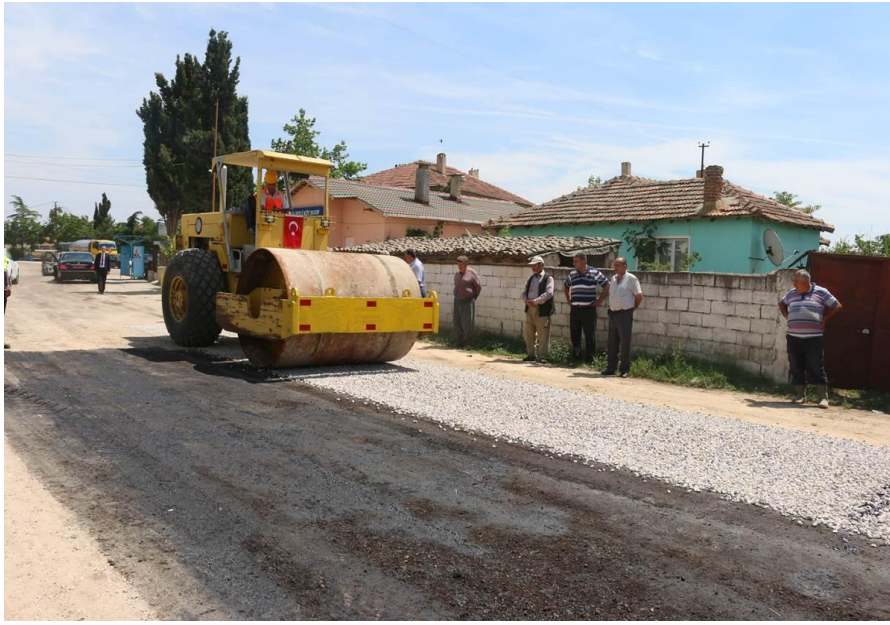
Sıcak asfalt dökümü çalışmaları
