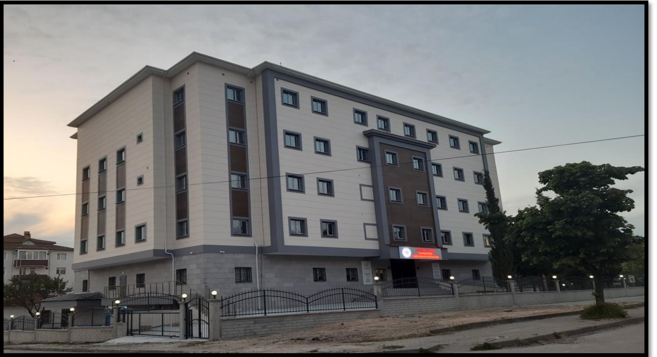
Lüleburgaz İlçe Sağlık Müdürlüğü +2 No'lu ASM +SHM+112 AŞİ Yapım İşi Fotoğraf
