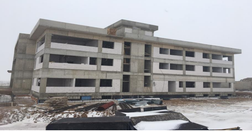
112 Acil Çağrı Merkezi Binası İnşaatı.
