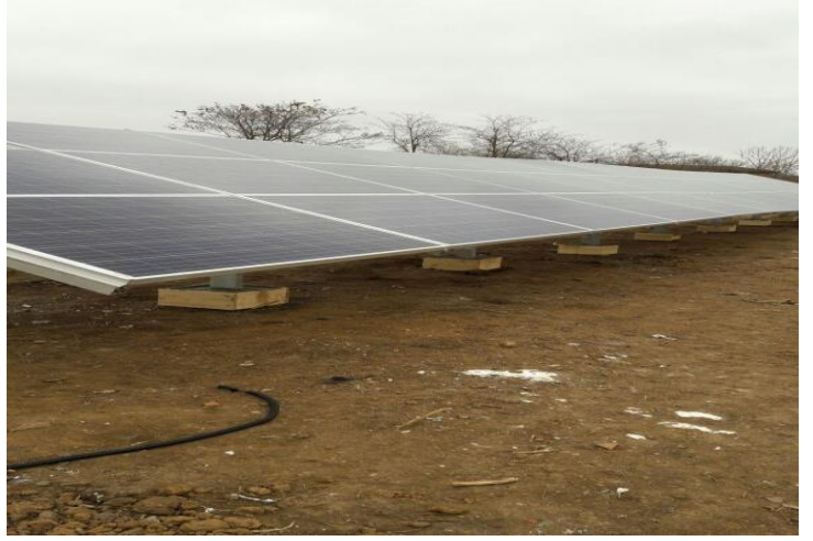
Karincak-Üsküpdere Köyleri İçme Suyu Güneş Enerji Sistemi Yapılması
