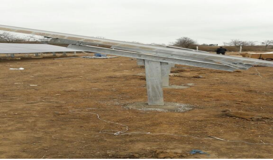
Karınca-Üsküpdere Köyleri İçme Suyu Güneş Enerji Sistemi Yapılması
