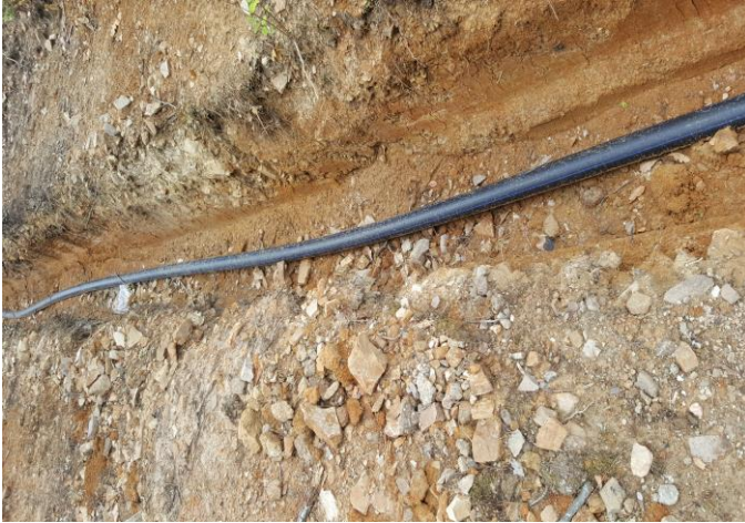
Avcılar -Hudut Karakolu İçme Suyu
