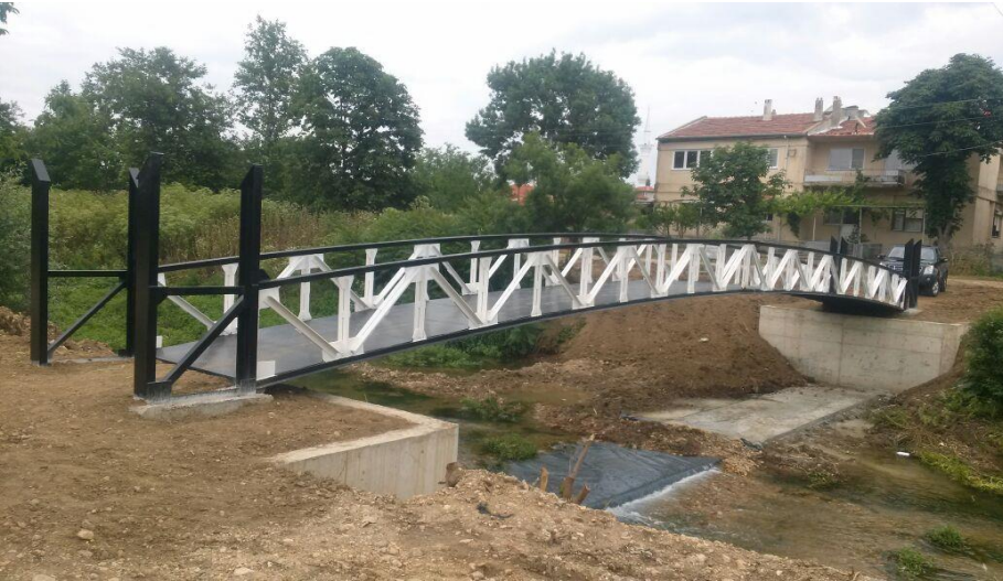
Pınarhisar İlçesi Sötlöce Köyü Yaya Köprüsü İnşaatı
