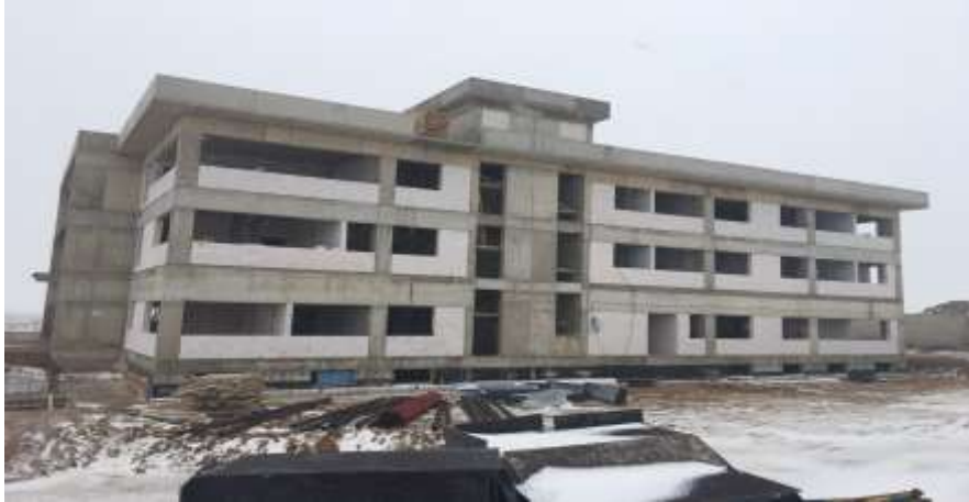
112 Acil Çağrı Merkezi Binası
