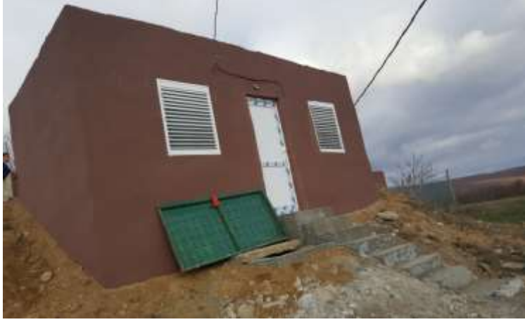
Sergen Köyü İçme Suyu Gömme Depo Onarımı
