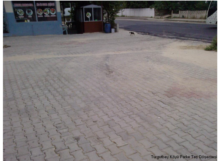
Turgutbey Köyü Parke Taş Döşemesi
