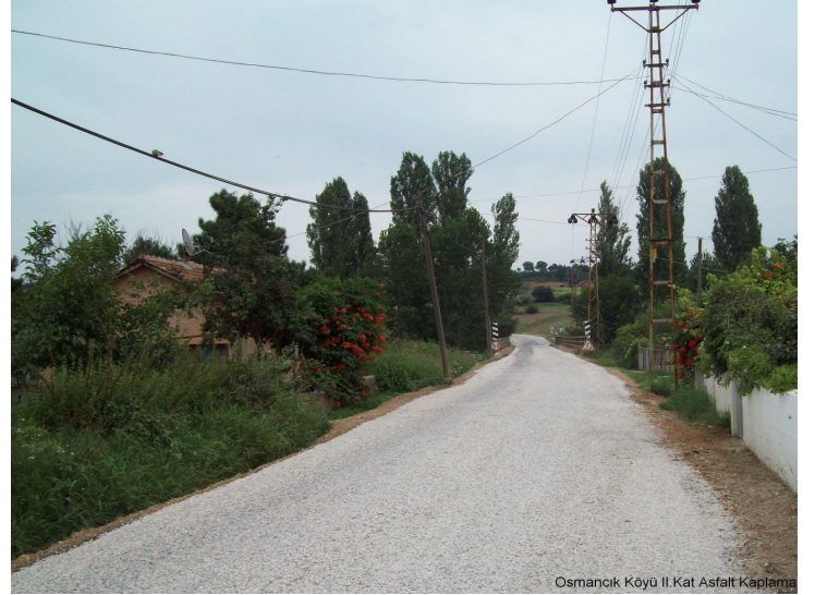
Osmançık Köyü II. Kat Asfalt Kaplama
