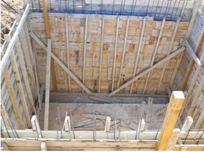
Pınarhisar İlçesi Kurudere İçme Suyu Depo İnşaatı
