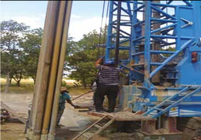
Lüleburgaz Çeşmekolu Köyü Sondaj Çalışmaları
