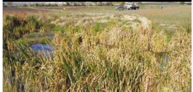
Vize Okçular Doğal Arıtma Tesisi
