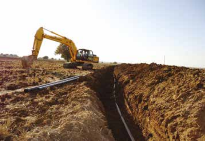
Kırklareli-Pınarhisar-Tozaklı Köyü İçme suyu İkmal Onarım İşi
