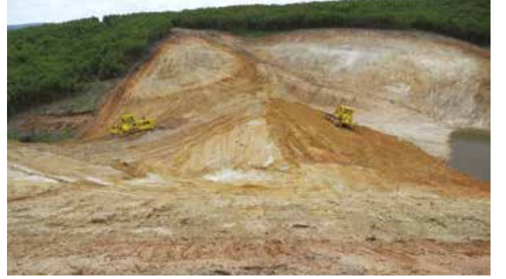
Kırklareli-Vize-Küçükayla Köyü Hayvan İçme suyu Gölet İnşaatı
