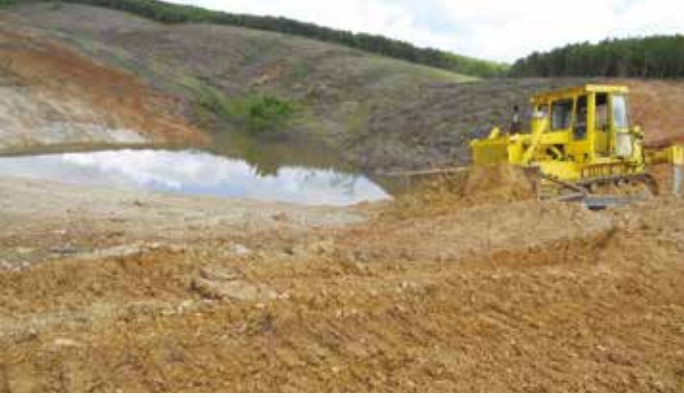
Kırklareli-Vize-Küçükayla Köyü Hayvan İçme suyu Gölet İnşaatı
