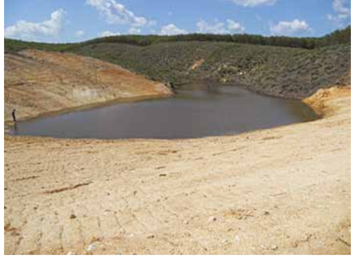
Demirköy İlçesi Beğendik Köyü H.İ.S. Göleti
