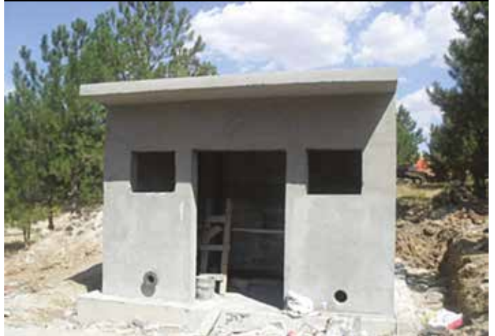
Babaeski İldeniz Kışlası İçme Suyu İnşaat Çalışmasından Örnekler
