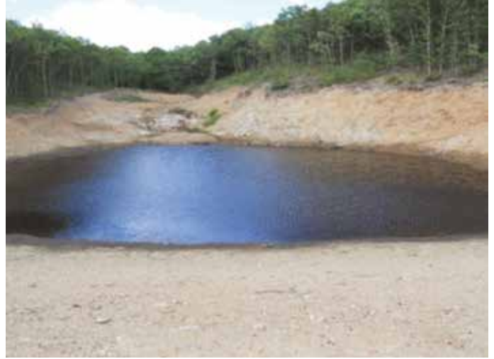
Demirköy İlçesi Beğendik Köyü H.İ.S. Göleti
